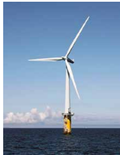
Las turbinas eólicas costa afuera como éstas, a menudo emplean zapatas o cajones, estructuras de acero y palas de turbinas de fibra de vidrio. (Fuente: Senu Sirnivas / NREL)
