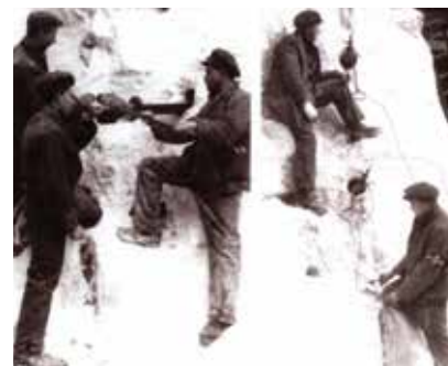
Colocación de explosivos en la pila de fertilizantes en el silo de BASF Oppau - 1920.
